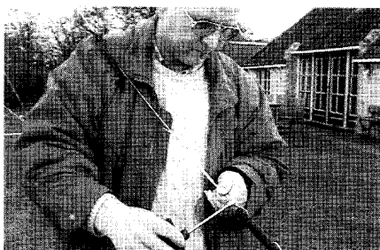
Het inkorten van de antenne. Aan beide zijden moest 75 cm worden ingekort. De overtollige antennedraad werd terug gevouwen en met stripjes aan de antenne bevestigd.
